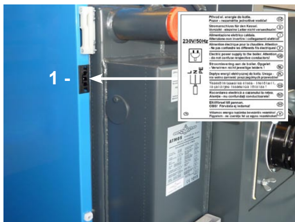
Conectori în partea dreaptă a cazanului
