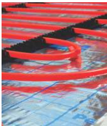
Montare țevă cu șină de fixare
