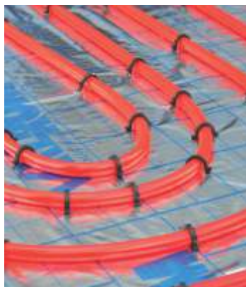
Montare țevă cu clips și tacker
