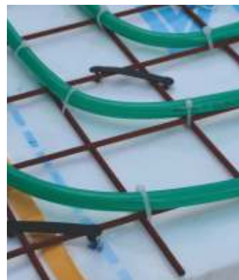
Montare țevă cu coliere pe plasă metalică
