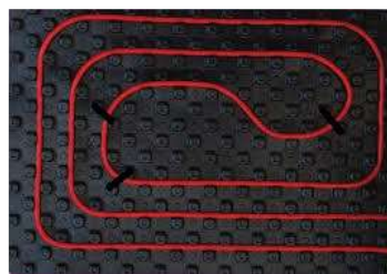
Exemplu - moduri de ancorare tubulatura
