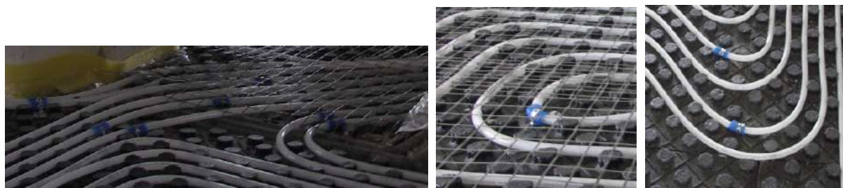
Exemplu - moduri de ancorare tubulatura
