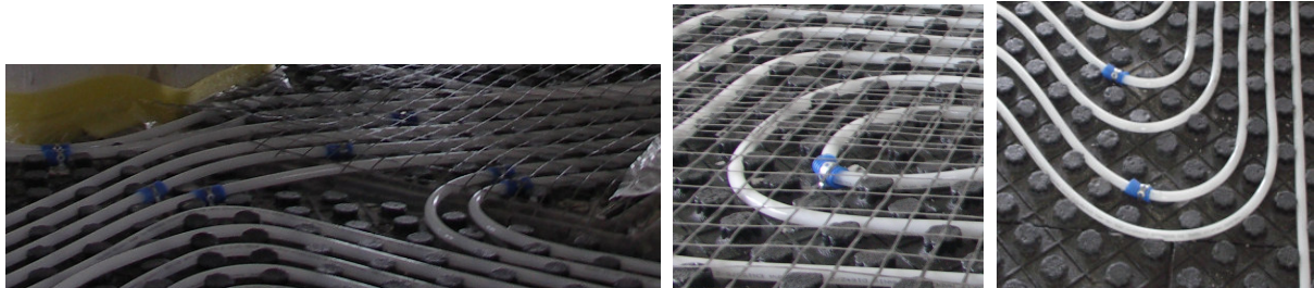
Exemplu - moduri de ancorare tubulatură
